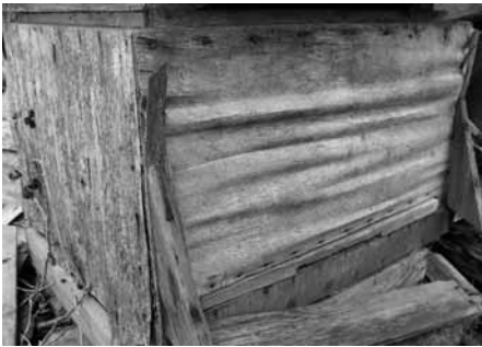
Rozklejenie się sklejki niewodoodpornej
