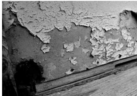
Łuszczenie lakieru z ścian korpusu
